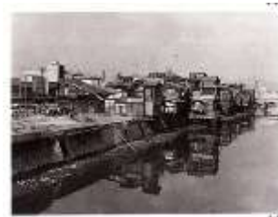
(昭和41年 猿猴川) 建物の一部を強制撤去
