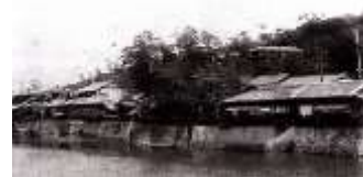
(昭和初期 京橋川) 比治山下付近の河岸
