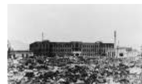
被爆後の状況
