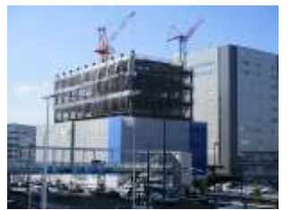
北口の再開発ビル建設中
