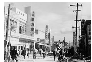
昭和24年、道路が拡張されたが、電柱は残る（佐々木雄一郎撮影）
