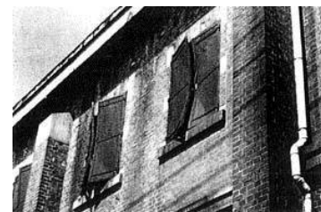
爆風により変形した鉄屑
