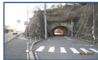
玖波隧道、左は国道2号
