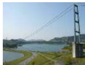
水の郷大吊り橋(316m)
