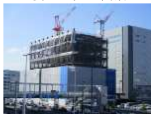
北口の再開発ビル建設中
