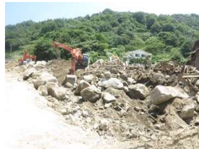
今回の災害で著しく処理困難なコア・ストーン群、早急な対策が必要
