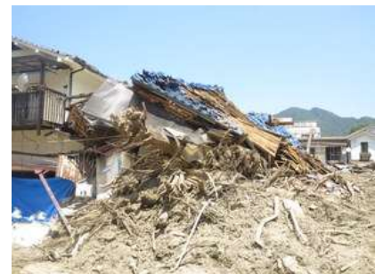
7月の大豪雨で山際付近に流出してきた土砂・流木等で破壊された家屋
