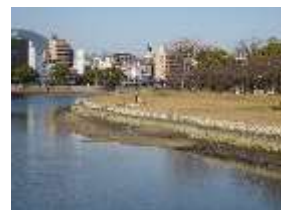
基町環境護岸(本川)
