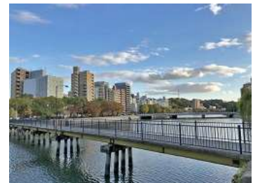
京橋川左岸柳橋下流
