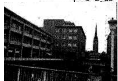
写真ショッピングセンター連絡デッキから尖塔(1971年筆者撮影)
