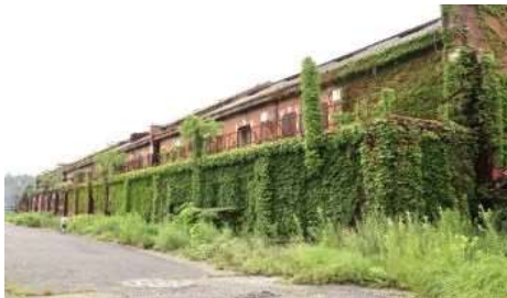
○被服支廠4号棟と薫風寮
